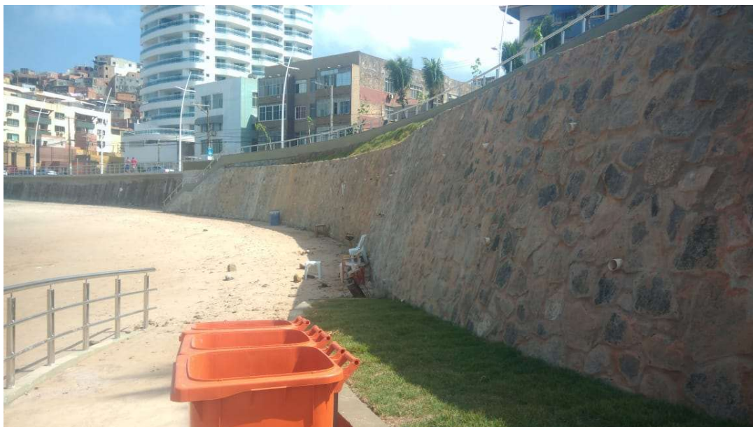
Figura 9: Muro de pedra argamassada
