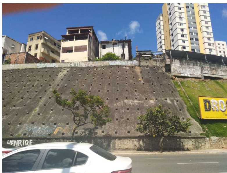
Figura 20: Mau acabamento das regiões limítrofes
